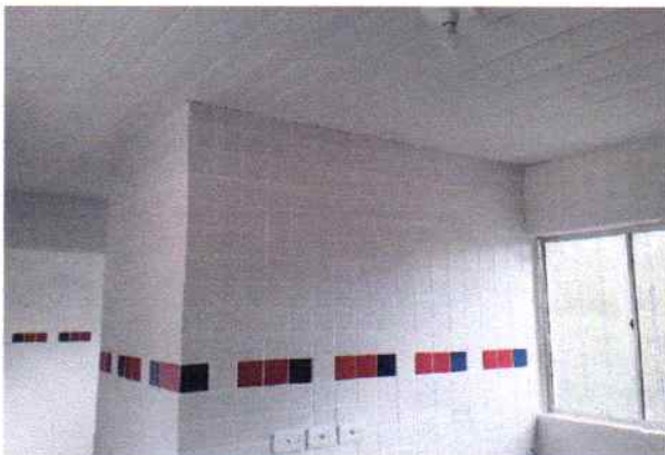
FOTO 5 - VISÃO INTERNA DO POSTO DETALHE DA CERÂMICA ASSENTADA CONFORME PROJETO, ESQUADRIAS DE ALUMÍNIO, E INSTALAÇÕES ELÉTRICAS
