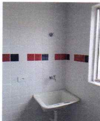
FOTO 10 - VISÃO INTERNA DO POSTO DETALHE DO TANQUE DE LOUÇA ASSENTADO, CERÂMICA ASSENTADA CONFORME PROJETO, E INSTALAÇÕES ELÉTRICAS
