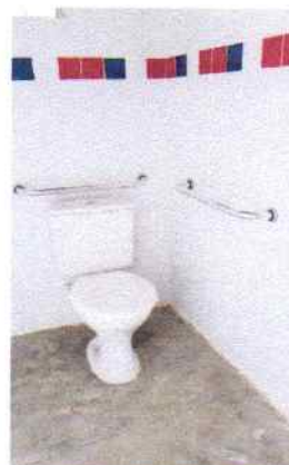
FOTO 12 - VISÃO INTERNA DO POSTO - DETALHE DO BANHEIRO PARA PCD EXECUTADO CONFORME PROJETO
