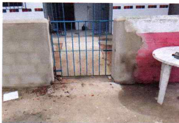
FOTO 8 - VISÃO EXTERNA DO POSTO DETALHE DO PORTÃO DE ENTRADA EXECUTADO, E ALVENARIA DO MURO EXECUTADA
