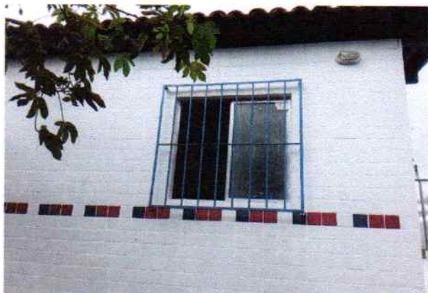
FOTO 9 - VISÃO POSTERIOR DO POSTO DETALHE DA GRADE DA JANELA, JANELA EM ALUMÍNIO, E CERÂMICA ASSENTADA CONFORME PROJETO
